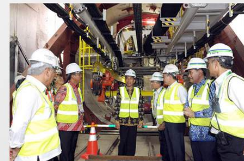
LRT Groundbreaking 9/9/2015 setelah mangkrak sejak Okt 2013
